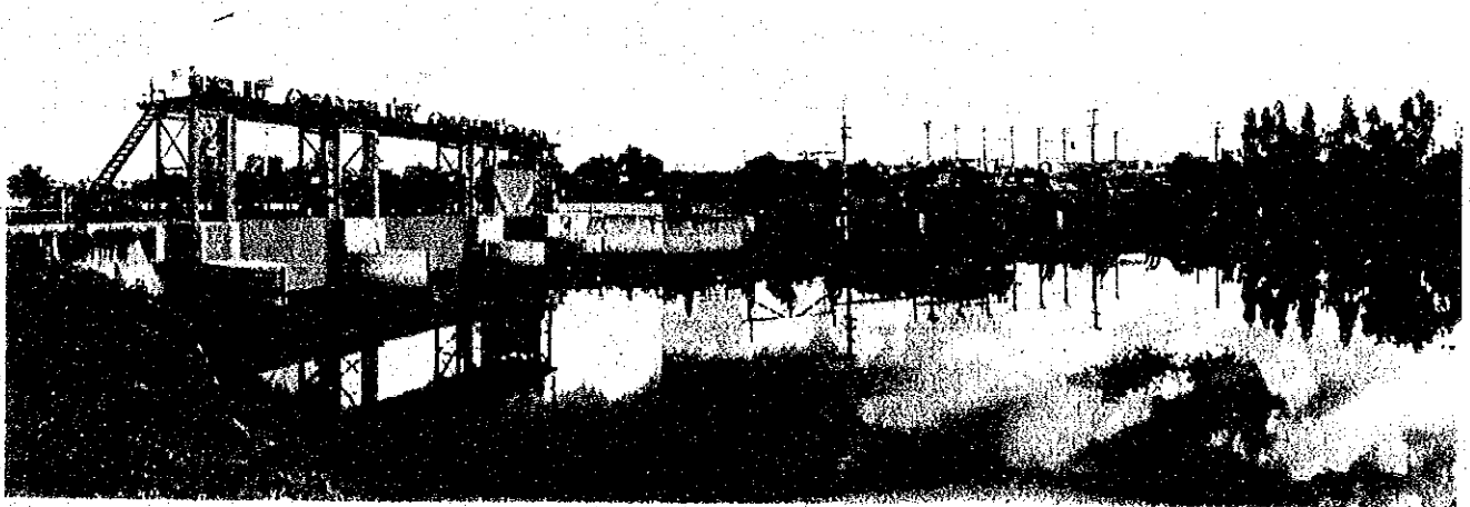
プラカノン・ポンプ場 (上流より右岸を望む)
