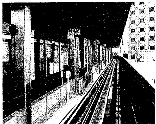
Platform Door (Kobe Port Liner)
