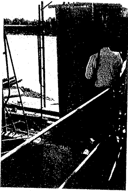
A 2 ~P 3 間のPC単純桁(6本中1本目) : PC鋼線緊張済(1987. 11. 21)
