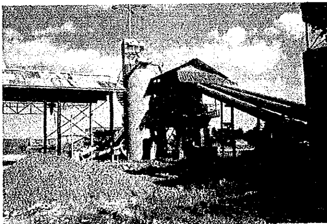
ツツナ橋建設現場から移設したコンクリートプラント (1987. 11. 21)
