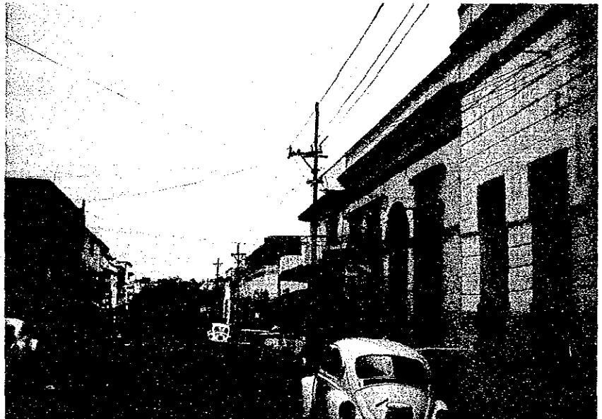
首都アスンシオン市内 の配電設備状況
