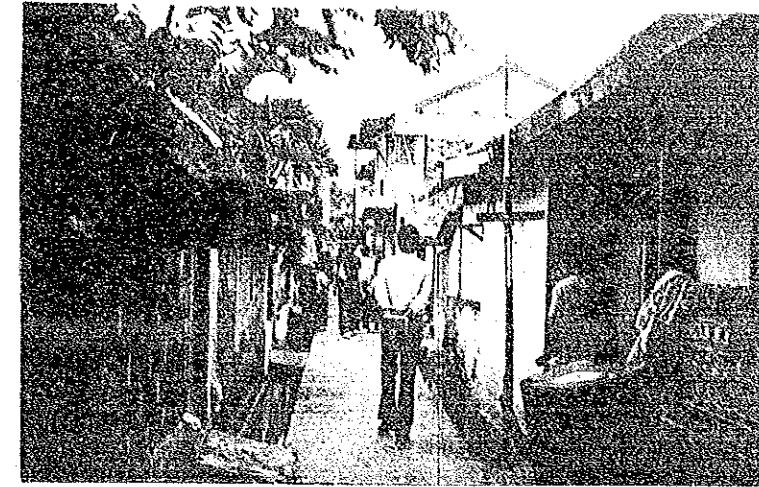
① KIPにより区画道路と側溝が整備されている。
