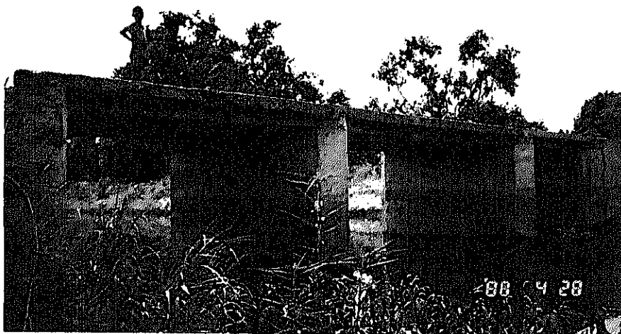
幹線用水路 既存道路橋
