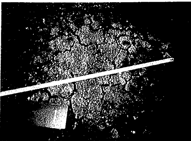
温水池天端のひび割れ状況（宝清県）
