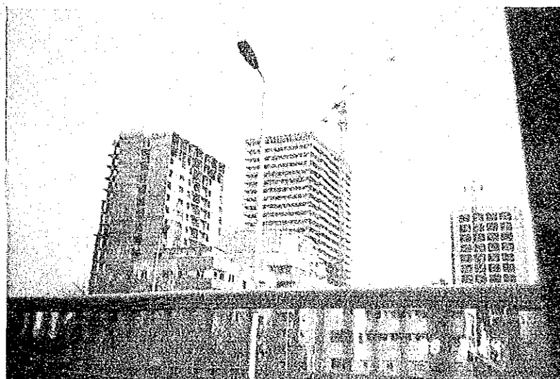
写真3-2 カイロ市内住宅建設工事
