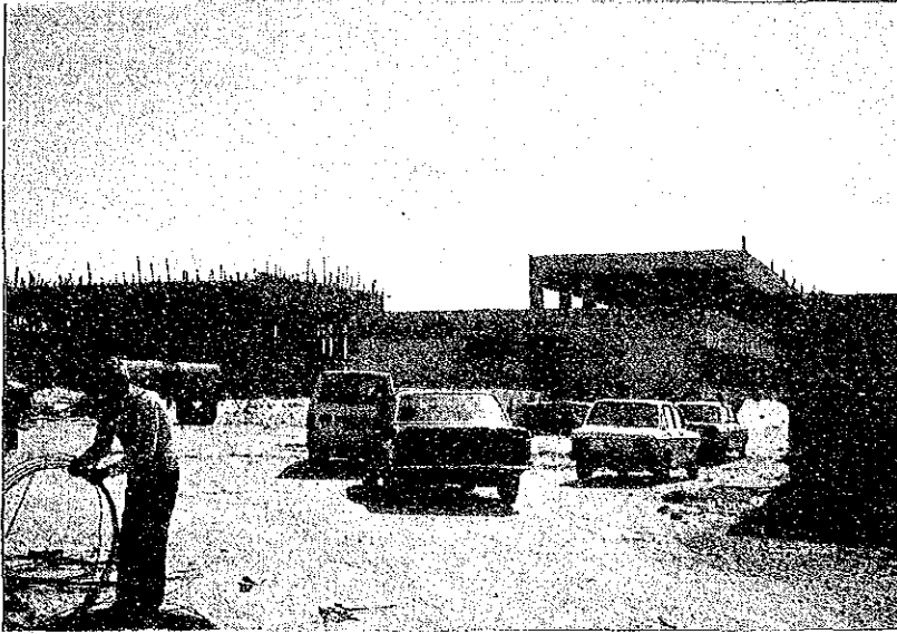
写真 3-10 HMTC 建設現場
