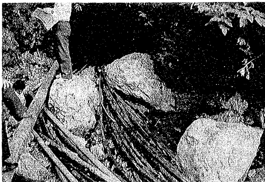
岩盤割れ目からの湧出水を、ビニール・ホースで取水
