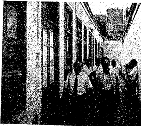
Evaluación de viviendas en el Centro de Lima
