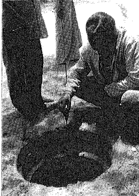
マンホール調査
