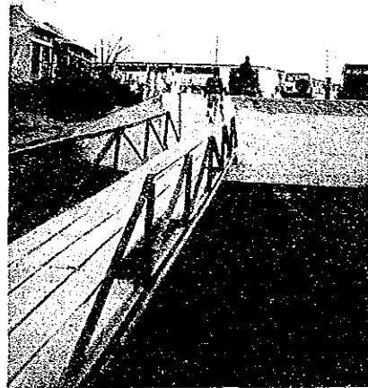
倉庫から船への積込棧橋 水位の上下によって護岸の溝に沿って棧橋のローラが動く。
