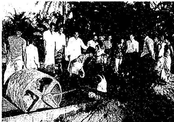
Feeder Road B の施工状況 舗装は道路用のブロック敷による。
