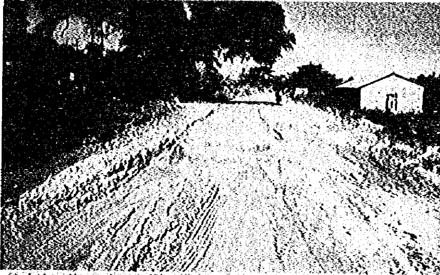
④イリンガ キロ口間；排水不良箇所
