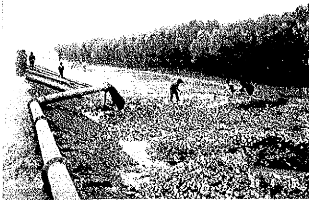
洞庭湖よりしゅんせつした泥による堤防改修工事
