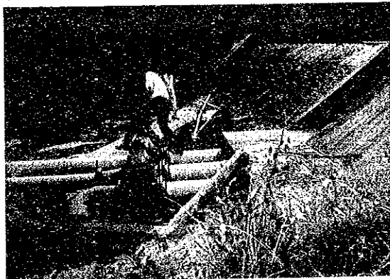
パンガの取水堰
