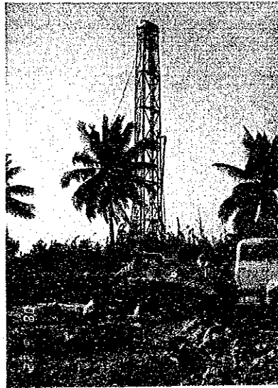
パツンタニの深井戸工事
