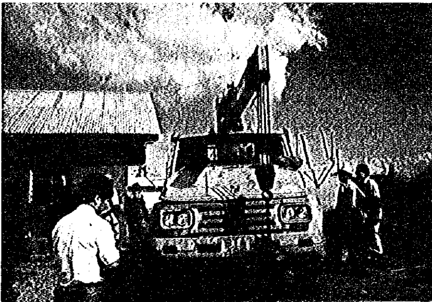
ボーリング・マシン
