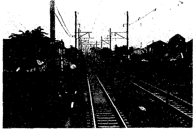
▲写-16 Western line(複線、電化完了)
