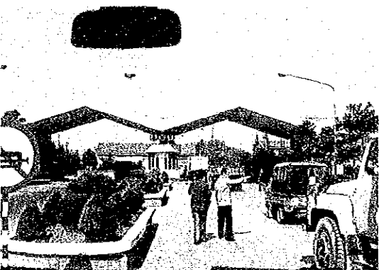
写真一一 浦東側打浦トンネル料金所
