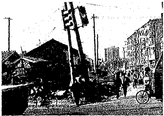
写真六 中山環状道路の拡幅工事
