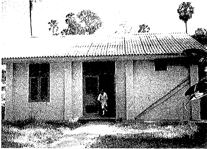
我が国が主要な資機材を供与し、ビルマ側が主に施工して完成した実験動物舎 外観（正面入口）
