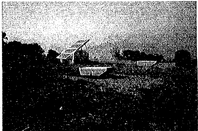
▲ 5-4-2 Lamidada空港 PAPI(進入角指主灯)
