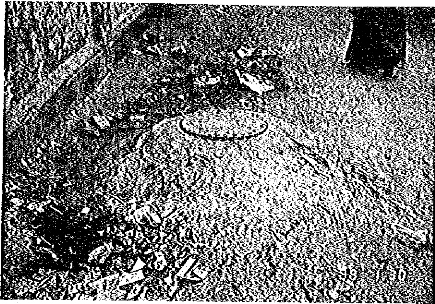
既設マンホール
