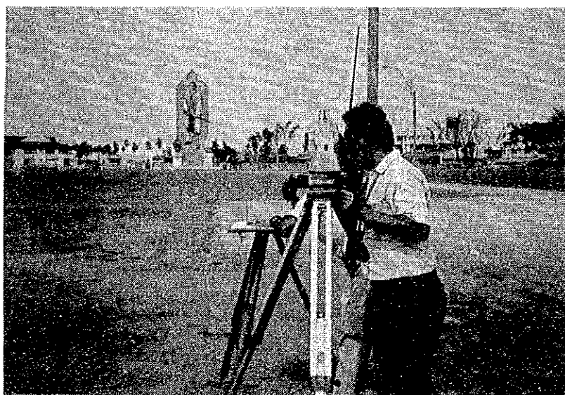
公園建設部分
