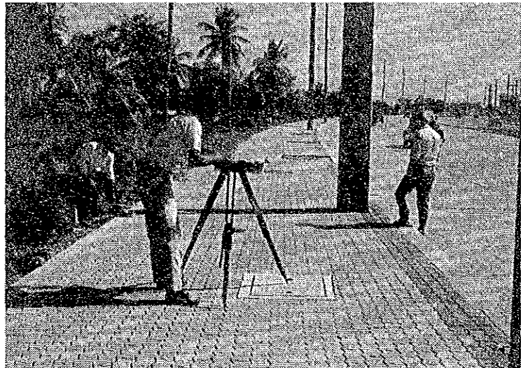
道路幅員の点検 (平板および巻尺)
