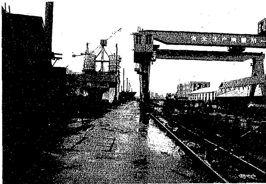
架橋地点現況(上段浦西側、下段浦東側主橋脚地点付近)
