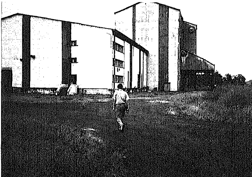
左：SODERIMの精米プラント。
