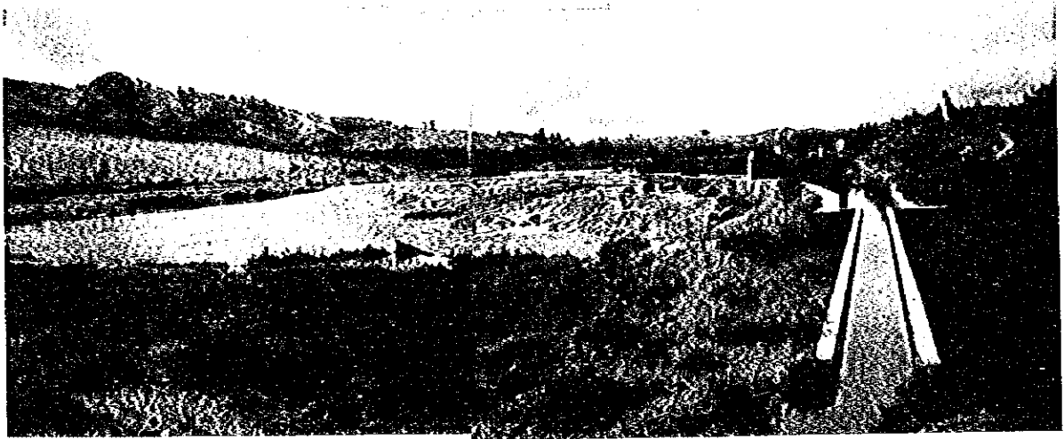
河川からの取水状況（取水断面巾0.5m×高0.5m） （ISETA NORD地区）
