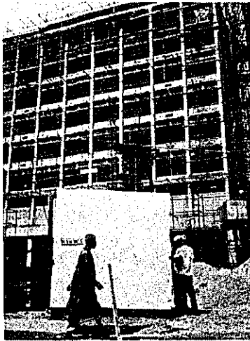
市内の高層建築現場
