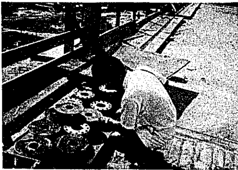
第2メインランドブリッジ のPCケーブルコーン（工 法には西独レオバ工法を採 用している）
