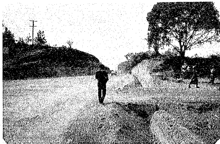
世銀融資による道路建設状況 (Gbarnga 近辺)
