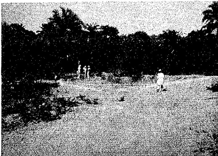
Travaux de nivellement pour un point géodésique (KINDIA).
