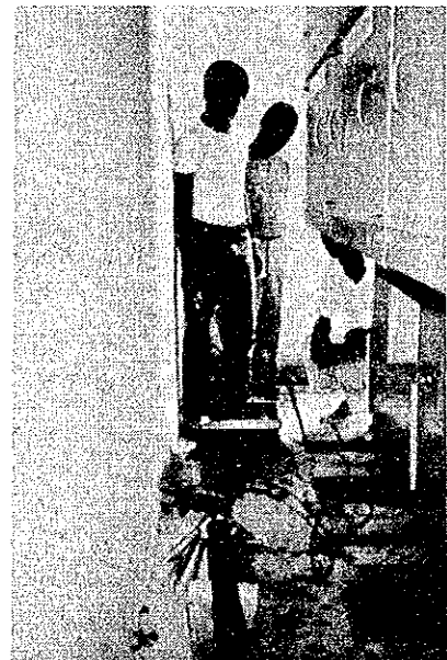
高圧ケーブル耐圧試験現場状況
