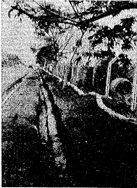
高圧ケーブル埋設用掘削溝状況
