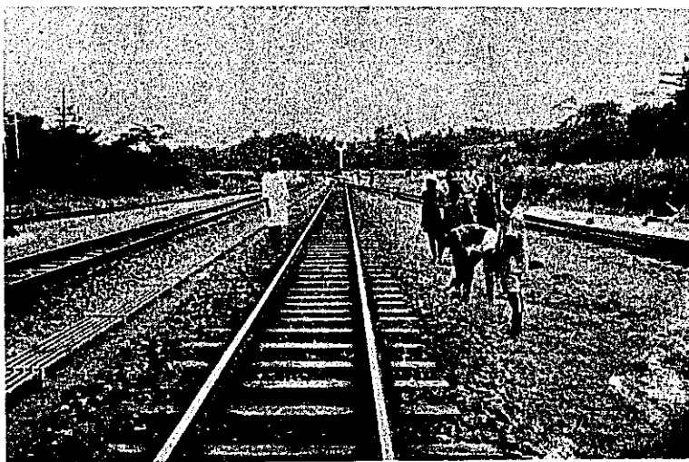
ある線路班員の草刈作業 左端は線路工手長
