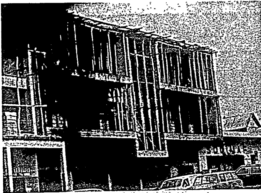
バフサム・工事中の一般建物 コンクリート型枠とサポートに木材を 使用。欧州風施工を持ち込んだ典型例。 一般にこの状態で1階はすでに営業等 をしている。これらは、西アフリカ一 帯に共通している。
