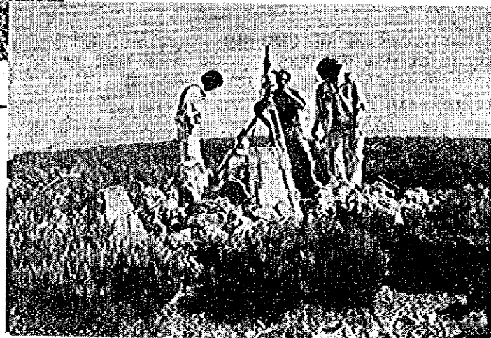
Etablissement de l'angle de direction à l'aide d'un compas-gyroscopique pour effectuer le piquage des points de contrôle déjà existants.
