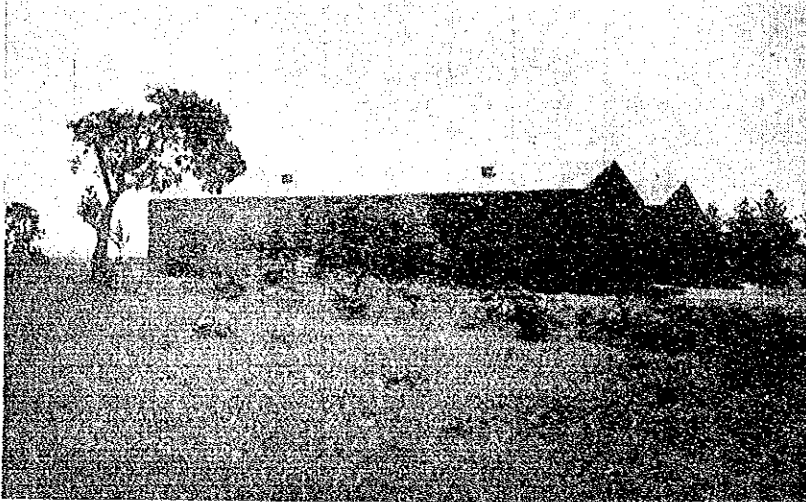
Mbozi Depot 1,000トン×2棟 (3625M×13.35M)
