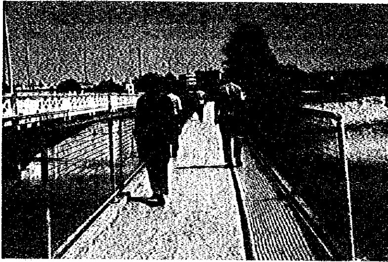
Selander Bridge の歩道橋
