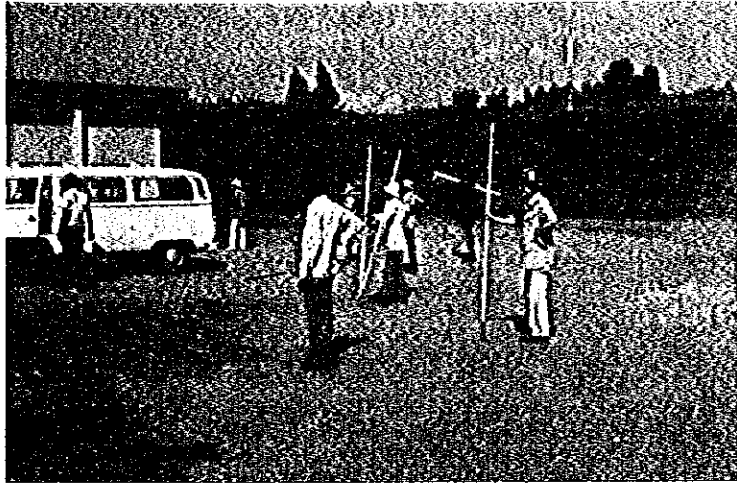
衛星通信地球局建設予定地の測量
