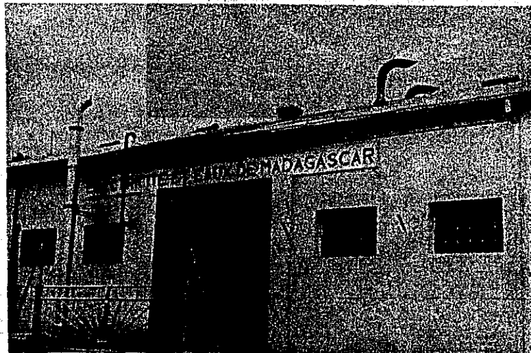
EEM Fianarantsoa デイジービル 発電所
