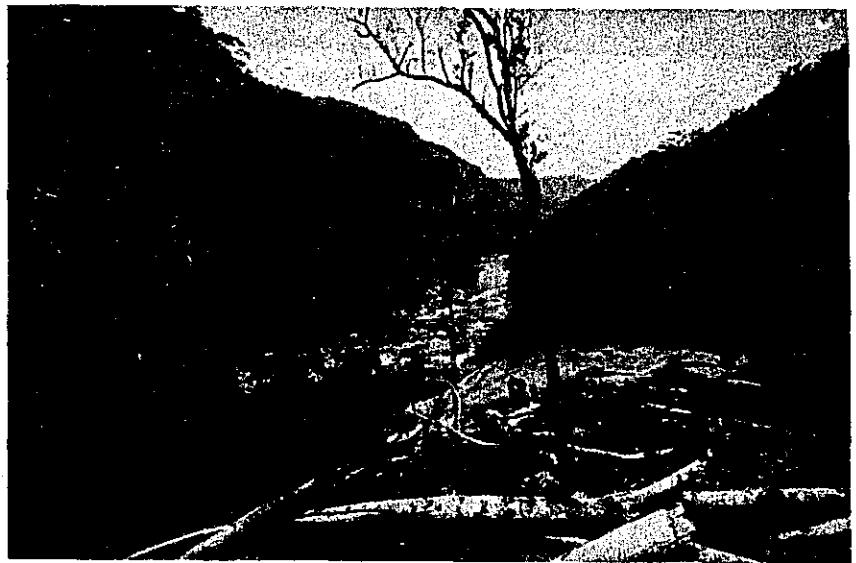
Manera No.1ダムサイト予定地点 を上流より眺む。
