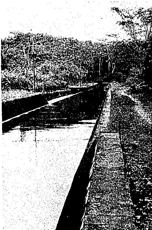
Volobé 発電所の導水路
