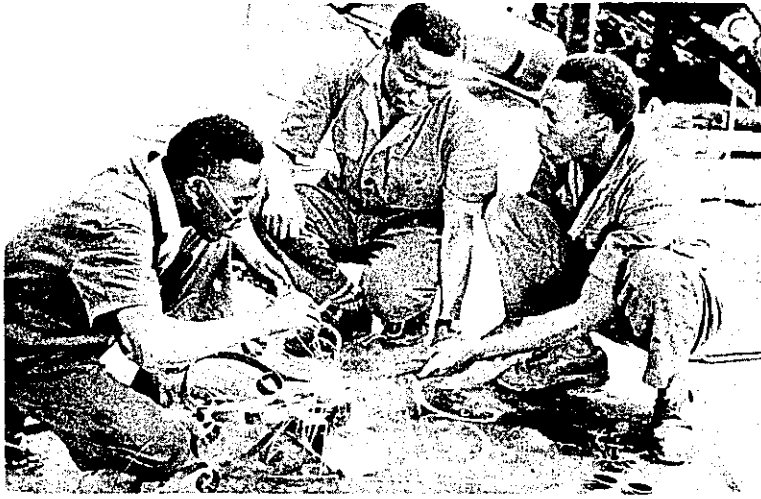
ガス溶接応用訓練
