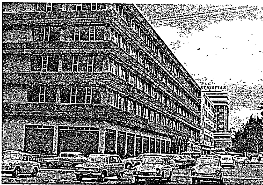
Fig. IV-14 IBTE (Filwoha Office)
