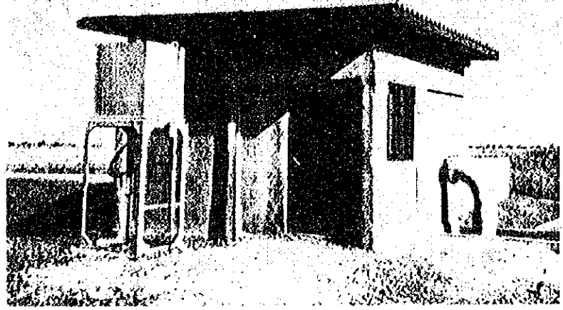
揚水機場（完成）
