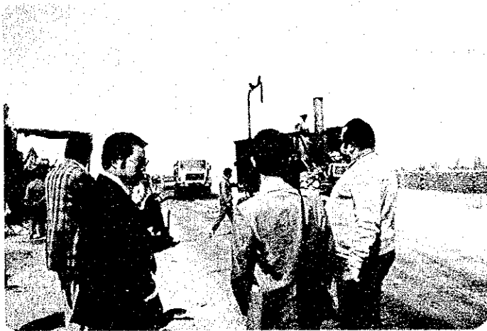
Mr. Safwatの案内により現場視察 ①アスファルト舗装工事(2月22日) (左はJICAカイロ事務所 藤田所員)
