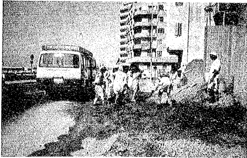
5-3-4 手練りコンクリートの現場
