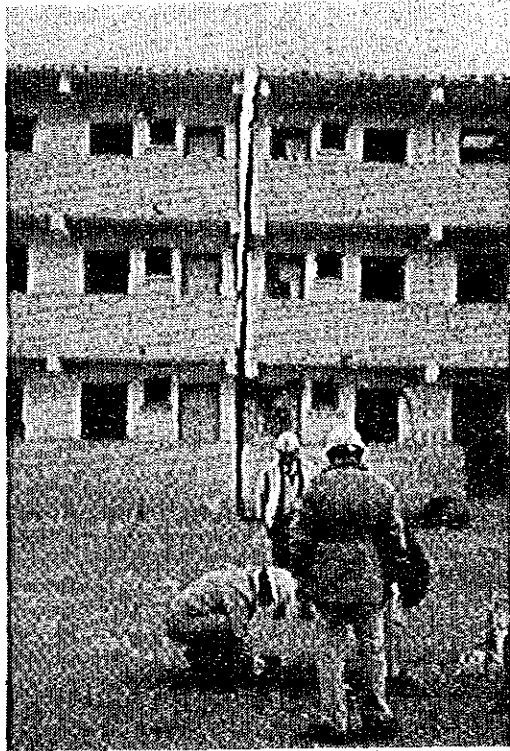
Photo 11 Il est indiqué de prévoir des joints de dilatation par intervalle de 25 m. aux bâtiments en béton. Beaucoup présentent la trace de heurts mutuels par les secousses sismiques, aggravant les dégâts.
