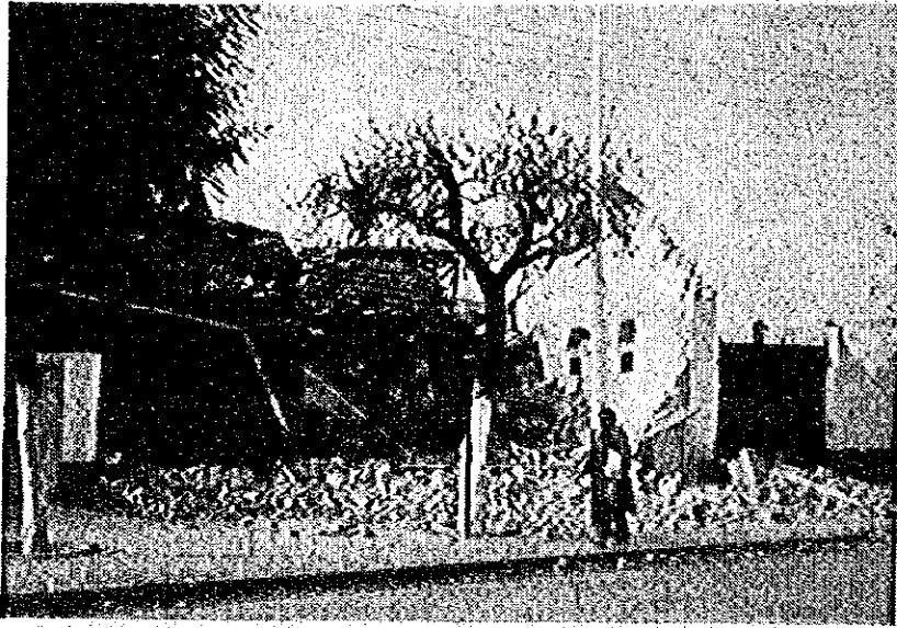
写真3 石造の民家は脆いこわれ方をしている
