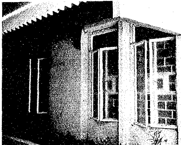
鋼製窓と防犯格子
