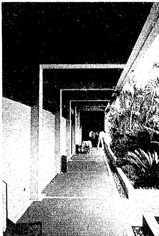
タンギリ材による開放廊下の天井、床は洗い出し床
