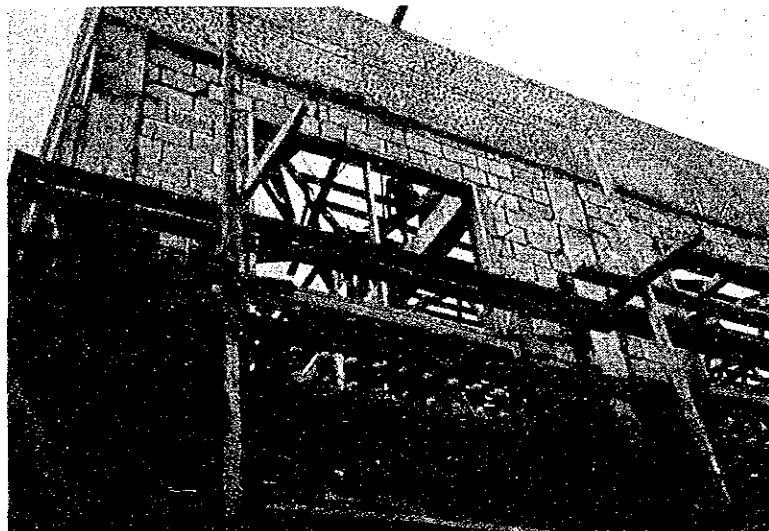
ブロック工事
