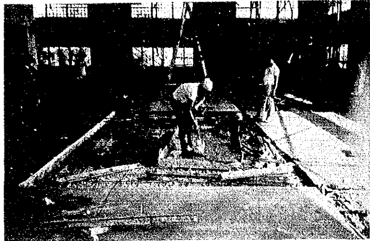
土間コン打設
