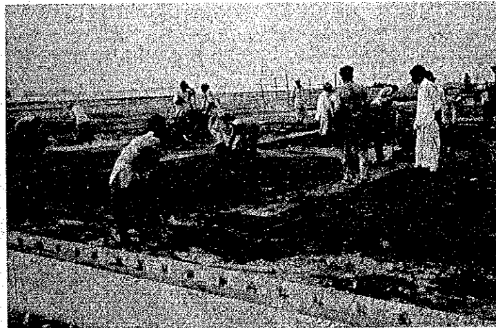
写-15. カラチ港 キーマリ突堤背後のコンテナヤードの舗装工事—鉄鋼敷設
