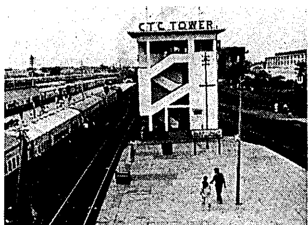
カラチ・カントンメント駅構内とCTCセンター
