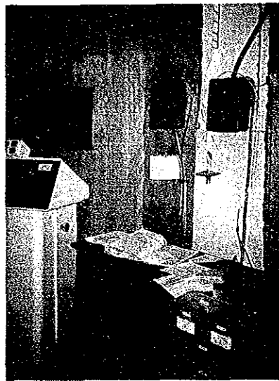
ガンダキ病院X線室。工事のおくれにより仮電源で作業している。
