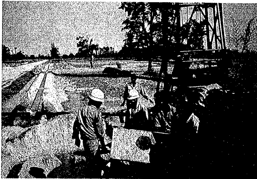
1981.4 浅井戸掘削現場 ( Saphi IMF )
