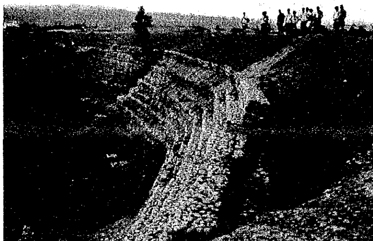
シズリ道路建設現場
