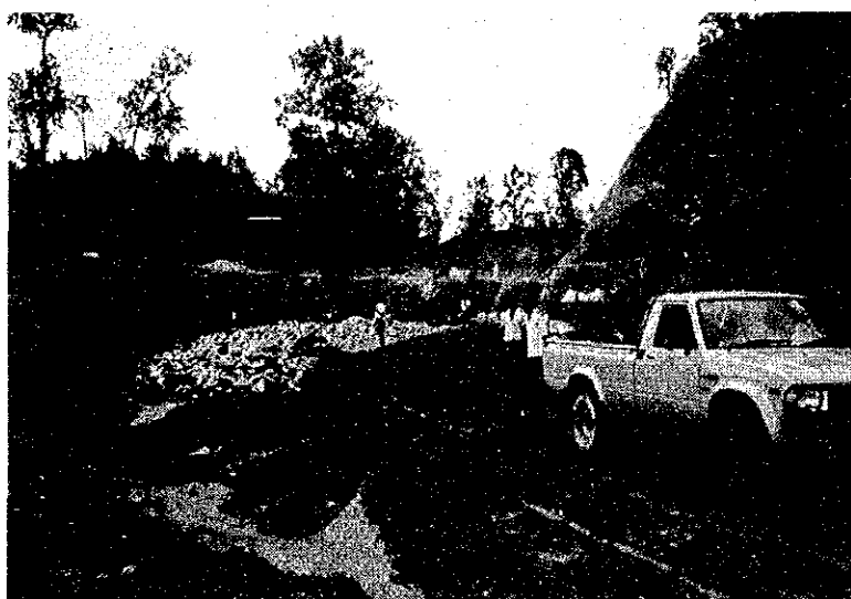
シズリ道路建設現場
