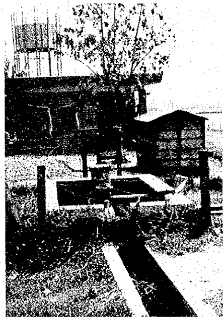
Photo 8. Hardinath 農場の揚水ポンプ
